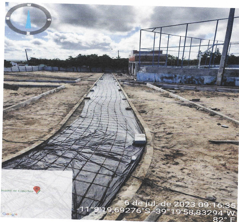
Foto 8: EXECUÇÃO DA LONA E MALHA DE FERRO
