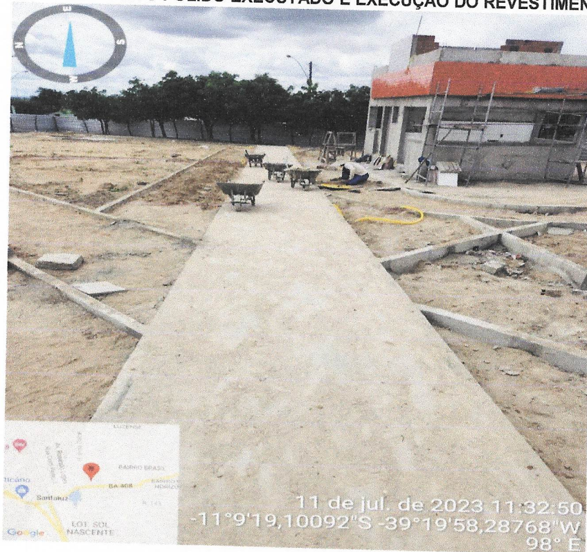
Foto 12- CONCRETO POLIDO EXECUTADO
