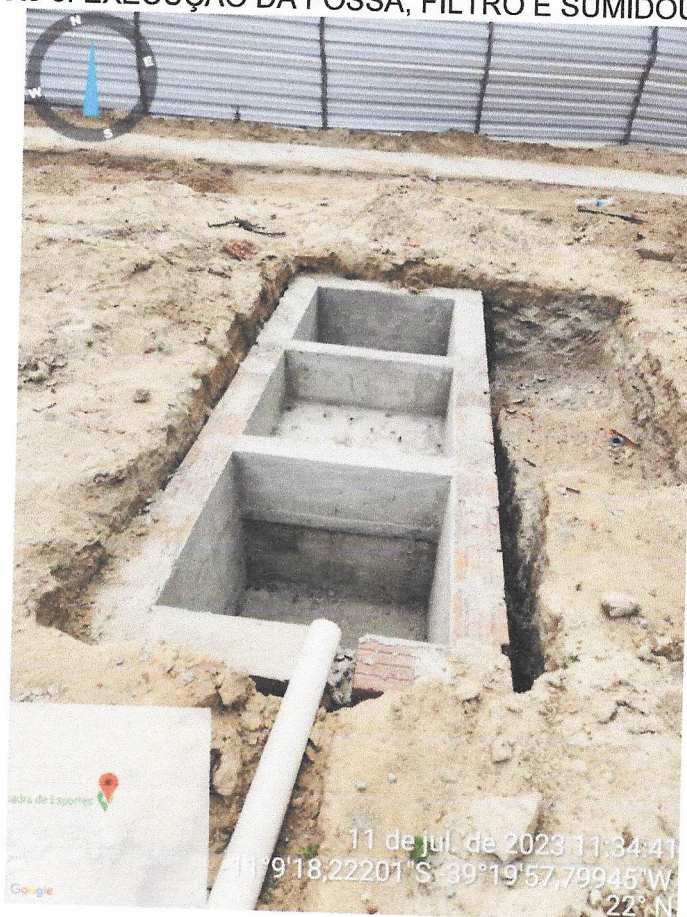
Foto 6: EXECUÇÃO DA FOSSA, FILTRO E SUMIDOURO
