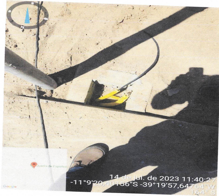
Foto 24- EXECUÇÃO DA CAIXA DE PASSAGEM E PASSAGENS DOS ELETRODUTOS E FIOS
