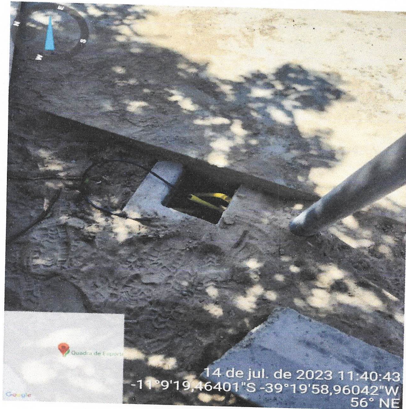
Foto 25- EXECUÇÃO DA CAIXA PASSAGEM E PASSAGEM DE ELETRODUTOS E FIOS
