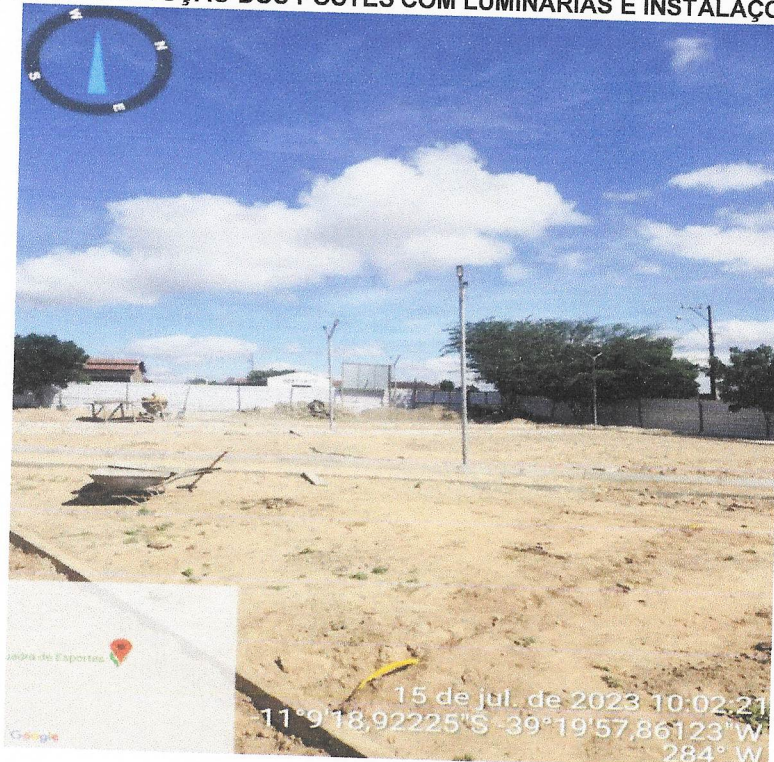
Foto 30- EXECUÇÃO DOS POSTES COM LUMINÁRIAS E INSTALAÇÕES
