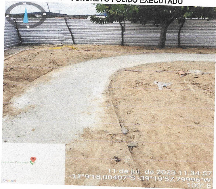
Foto 14- CONCRETO POLIDO EXECUTADO
