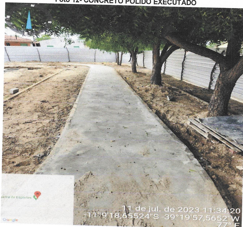
Foto 12- CONCRETO POLIDO EXECUTADO
