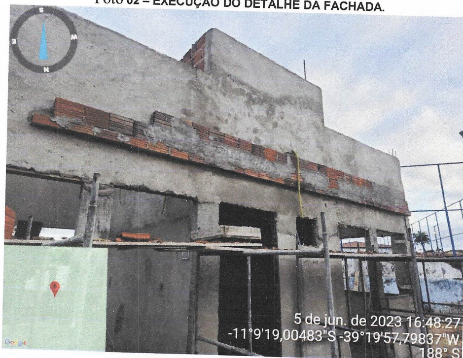
Foto 02 – EXECUÇÃO DO DETALHE DA FACHADA.
