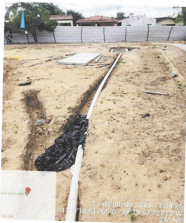
Foto 6: EXECUÇÃO DA FOSSA, FILTRO E SUMIDOURO
