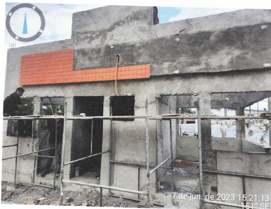
Foto 04 – EXECUÇÃO DO REVESTIMENTO
