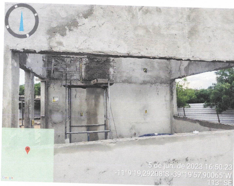
Foto 01 – EXECUÇÃO DE CHAPISCO E REBOCO
