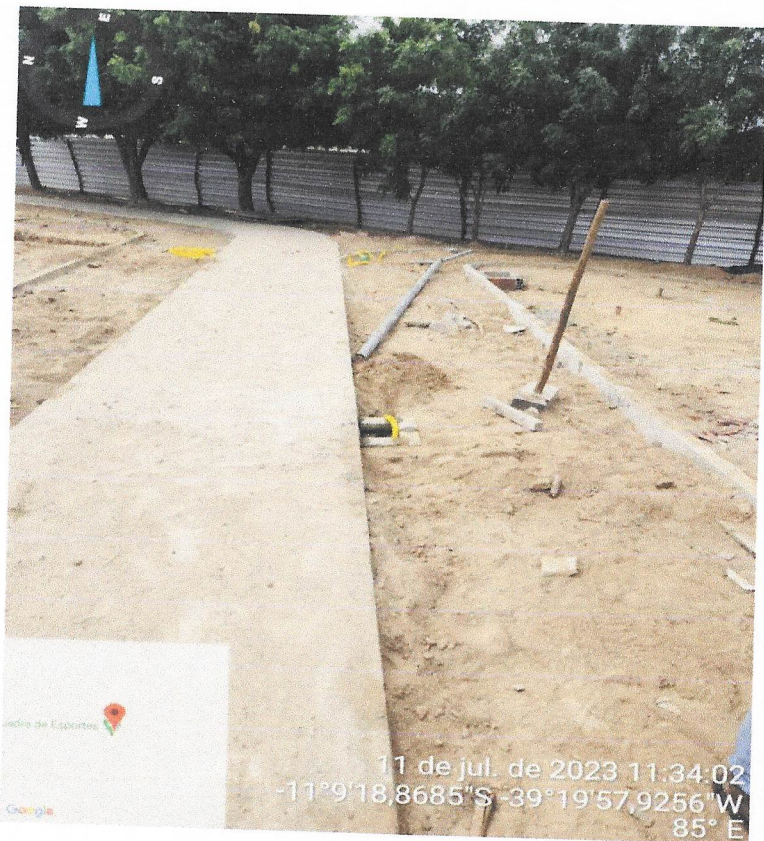
Foto 14- CONCRETO POLIDO EXECUTADO
