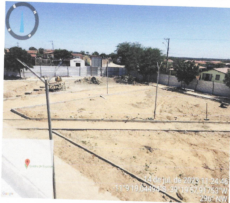
Foto 29- EXECUÇÃO DOS POSTES COM LUMINÁRIAS E INSTALAÇÕES
